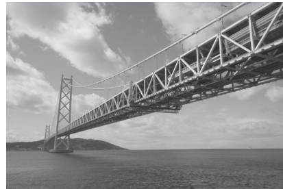
図 1.9 明石海峡大橋
