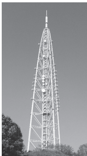
図 1.2 通信用鉄塔 (長久手市)
