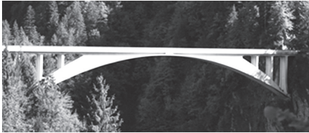
(a) ザルギナトーベル橋, コンクリートアーチ (スイス, マイヤール設計)
