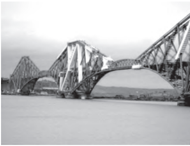
図 1.7 フォース鉄道橋（1893年、塗替え塗装工事中）
