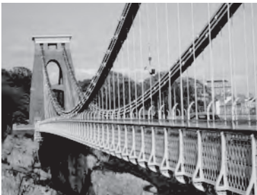
図 1.5 クリフトン吊橋 (1864 年)
