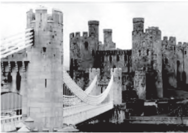
図 1.3 コンウェイ吊橋 (1826 年)
