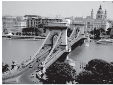
図 1.8 ブダペストの鎖橋（1849年、吊橋のケーブルがアイバーチェーンで鎖のように見える）
