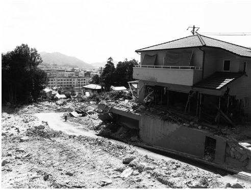
図 1.5 豪雨で発生した土石流によって被災した住宅地（2014年、広島市）
