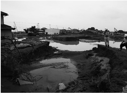
図 1.2 台風による豪雨で決壊した堤防 (2015 年, 茨城県の鬼怒川左岸堤防)
