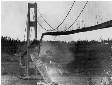
図 1.1 タコマ橋の崩壊†
